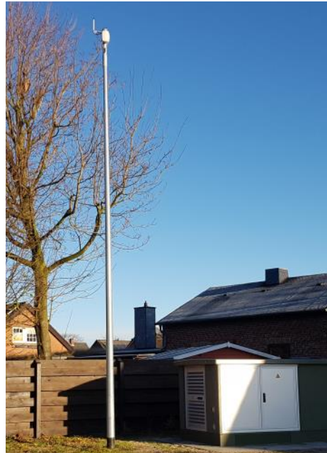
Netzstation und LoRaWAN-Sendemast
